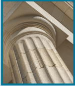
شكل 100 صخور كلسية تُستخدم في البناء.
