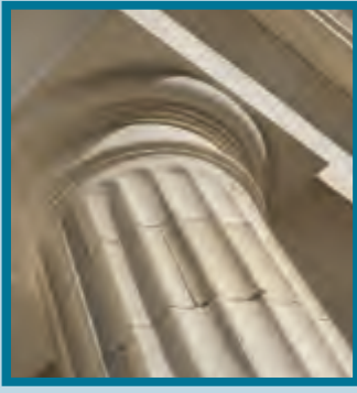
شكل 100 صخور كلسية تُستخدم في البناء.
