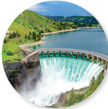
الشكل (9) بناء السدود
