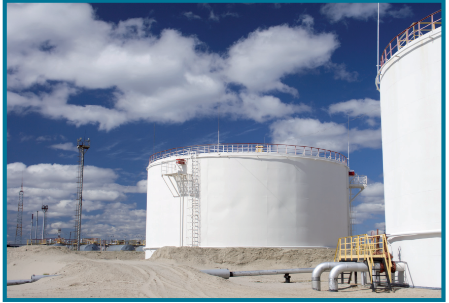
خزانات النفط في الكويت
