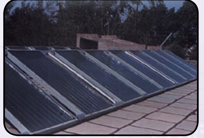
شكل (١-٢) - مجمعات الألواح المسطحة على أسطح المنازل
